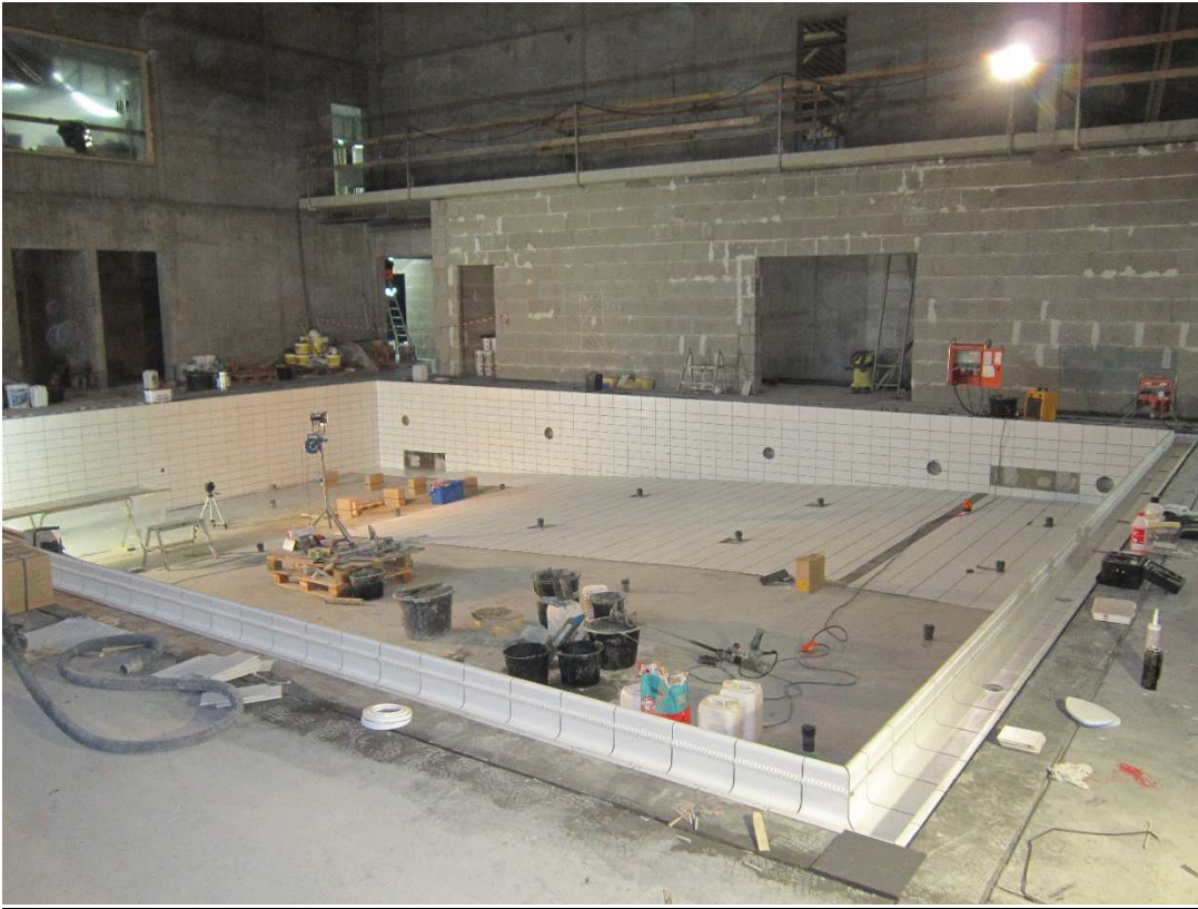
Flislegging av terapibasseng
