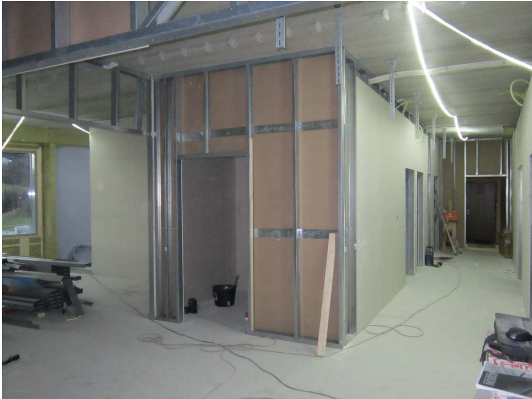
Deler av administrasjonsdelen 2 etasje.
