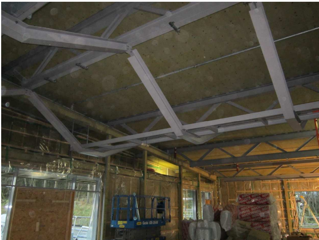
Brannisolering over himling inngangspartiet. Gangbroer er for tilkomst i driftsfasen.
